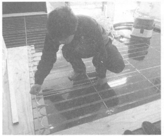
▲簡易に施工できる上貼り工法
