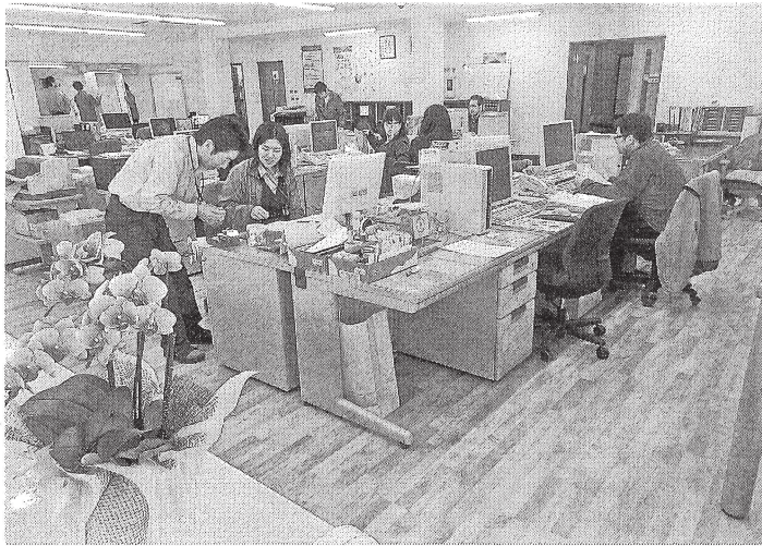
全面に床暖房を設置した本社事務所
